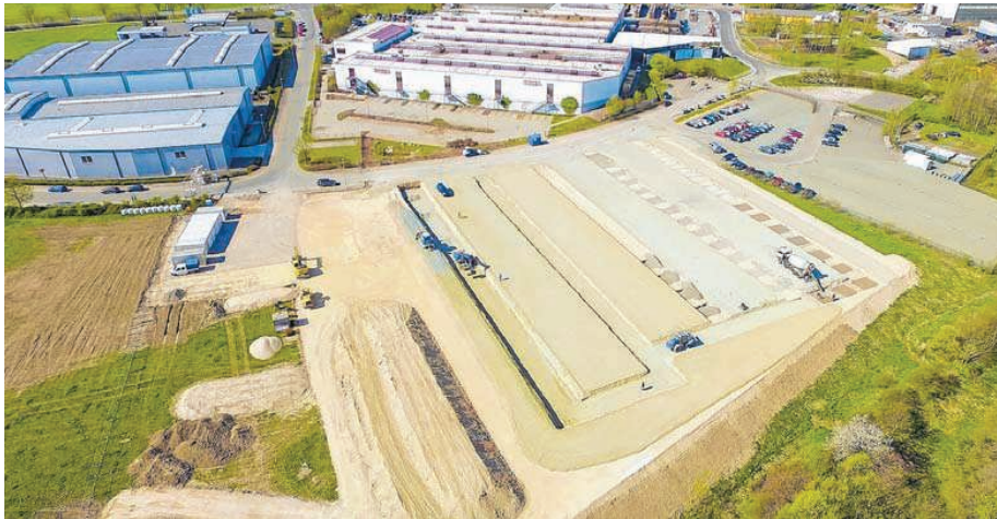
Die Grundrisse der neuen Hallen sind bereits gut erkennbar. Die zwischen Baustelle und Altstandort liegende Straße wurde für die Expansion des Formenbauers gekappt. Um die Zufahrt weiterer Anlieger des Industriegebiets zu gewährleisten, baute Kobra die rechts neben dem Altbau verlaufende Straße neu. Auf dem neuen Werksgelände ist Platz für sieben weitere Hallen. Mit dem Neubau verdoppelt Kobra seine Grundstücksanzahl. FOTO: CARSTEN STEPS
